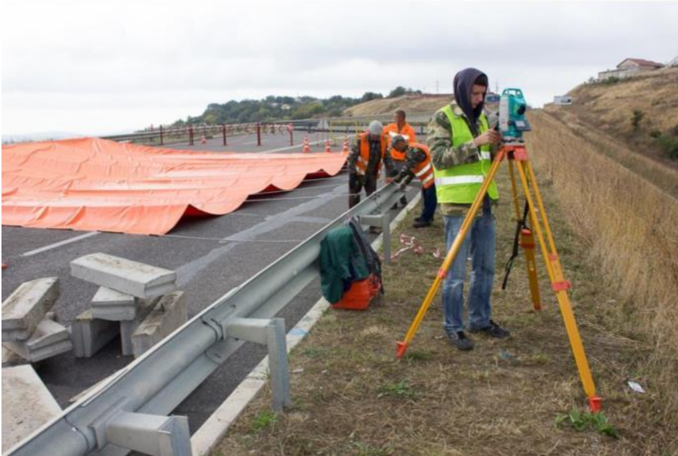
Процесс инженерно-геодезической съемки.
